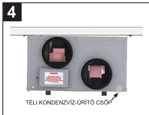
4. ábra Kondenzvíz-ürítő konfiguráció
